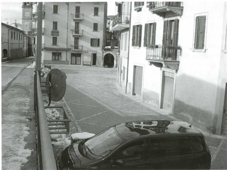
Un tratto della nuova pavimentazione di Piazza Olmo
